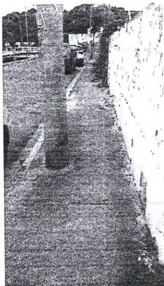
Fotografia 46. Calçada, altura do nº 2245
