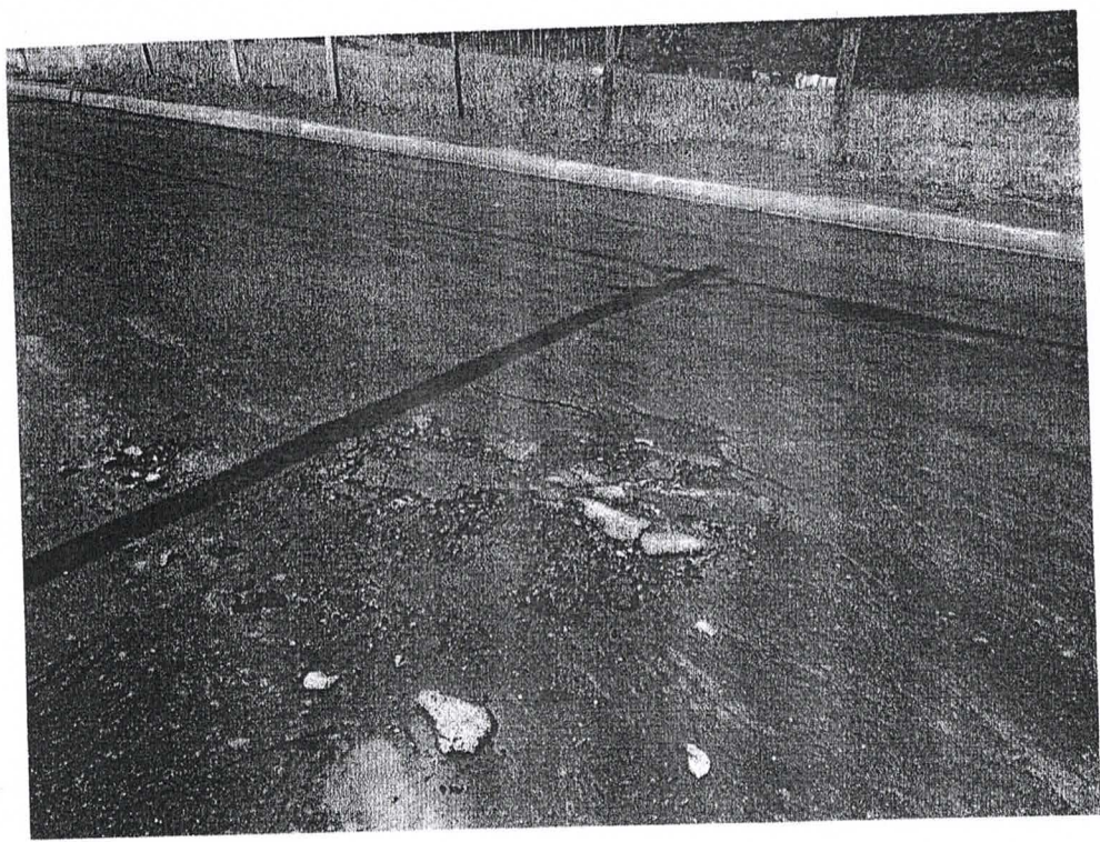
FOTO 04 – ASFÁLTO DANIFICADO.
