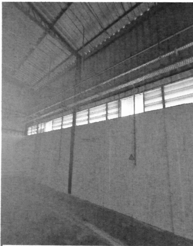
Foto 34- Vista parcial interna das venezianas industriais que promovem a ventilação e iluminação natural do galpão
