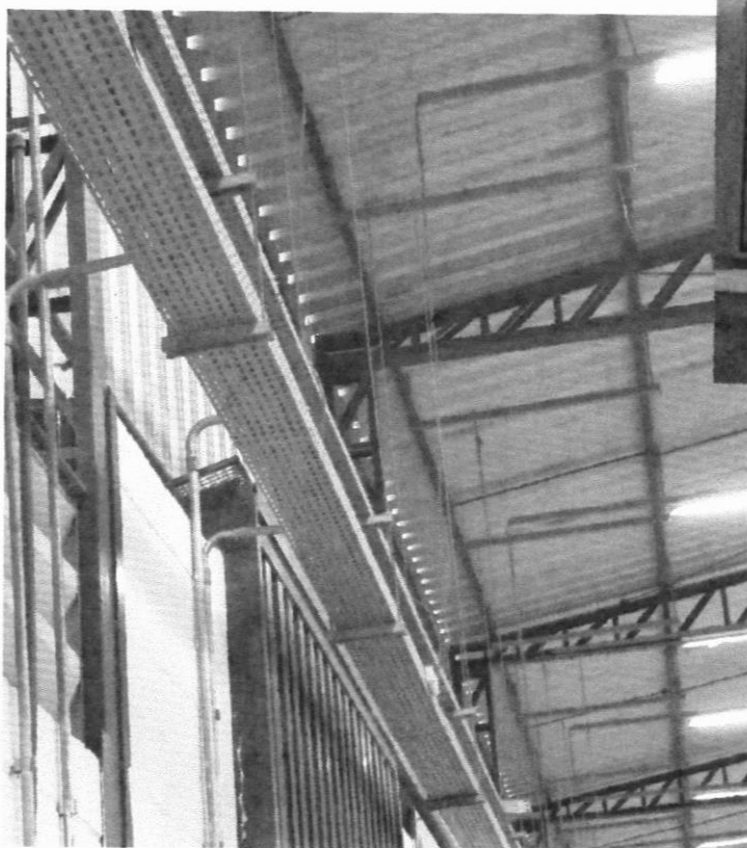
Foto 39- Vista da bandeja para cabos elétricos do sistema de instalações elétricas do Galpão
