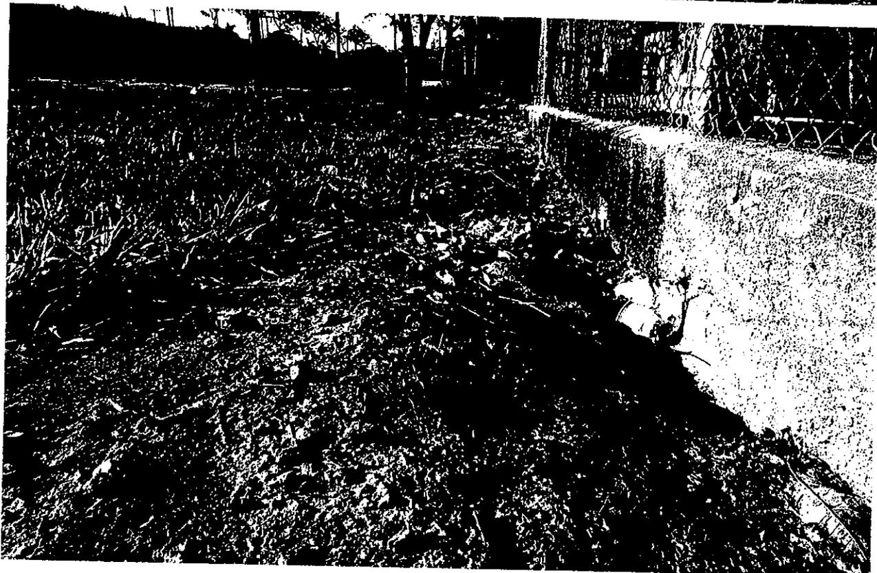
Figura 2 – Na Área Não Pavimentada do Estacionamento dos Alunos e Usuários do Campus Tecnológico do Ceeteps da cidade de Mococa existem muitos atoleiros que impedem o estacionamento de veículos, bem como a saída destes, em caso de chuvas. Percebe-se que existe também o início do assoreamento da área anexa à divisa ao campus.
