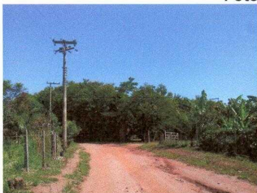
Foto: Estrada sem iluminação
