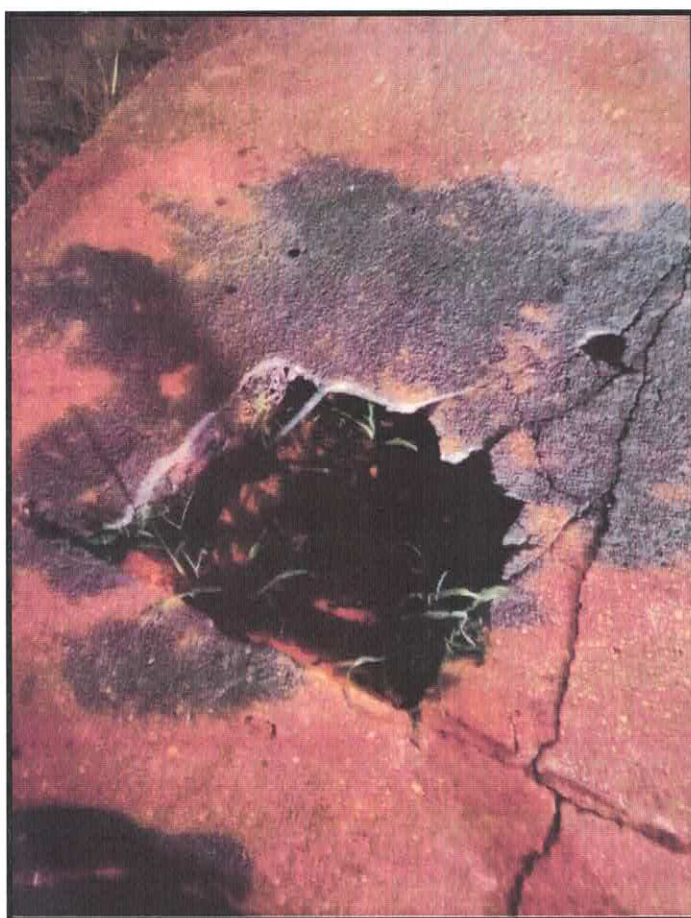
Imagens: rachaduras e falhas no calçamento da Praça da Cidadania.
