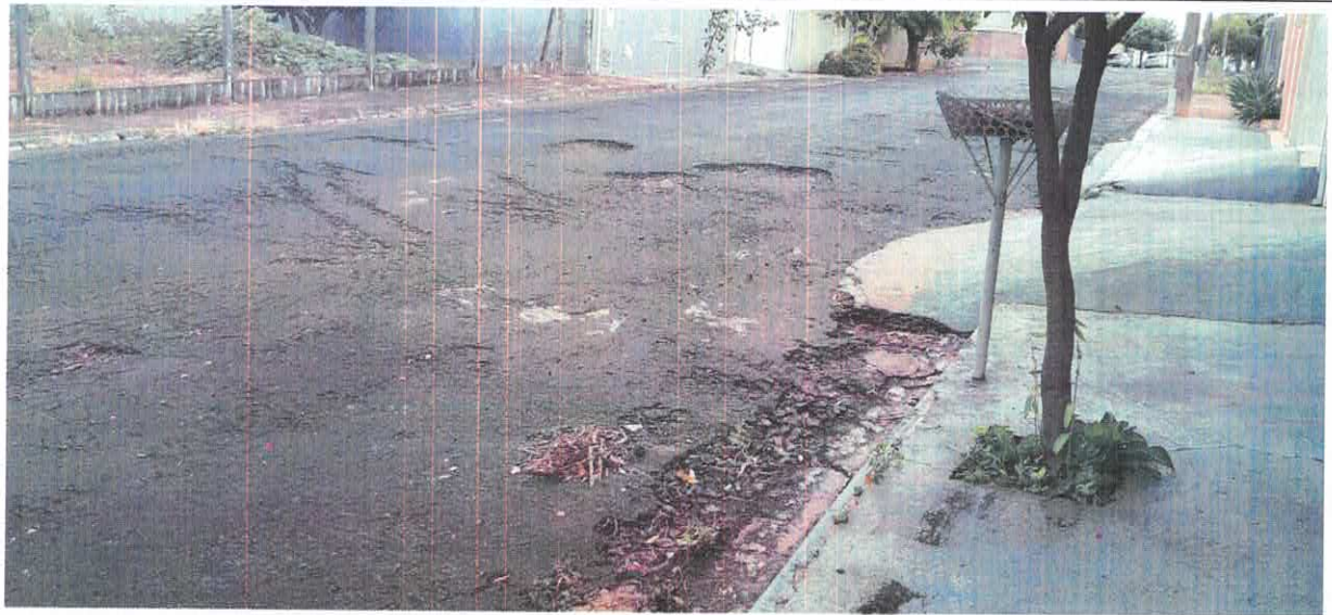
Anexo: Imagens da pavimentação da Rua João Moreira Sales, bairro Vila Santa Cruz.
