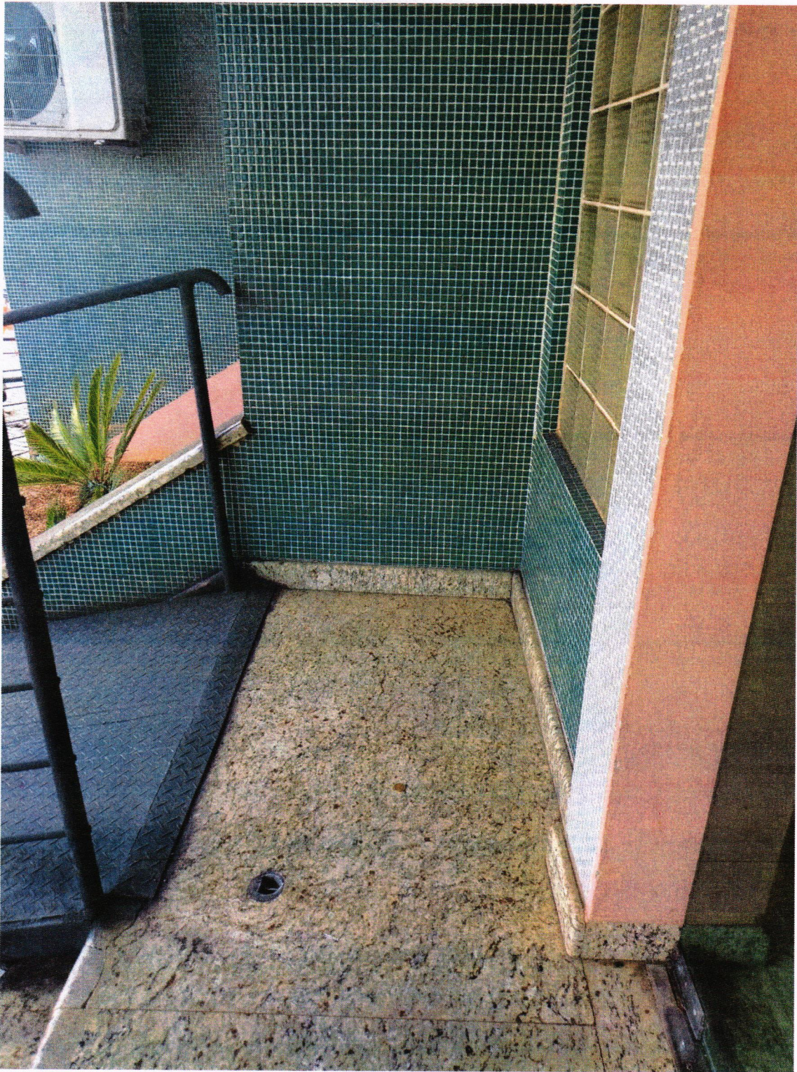
Imagens: curva pouco flexível para que o cadeirante possa manobrar em segurança e ter acesso ao atendimento no interior do prédio
