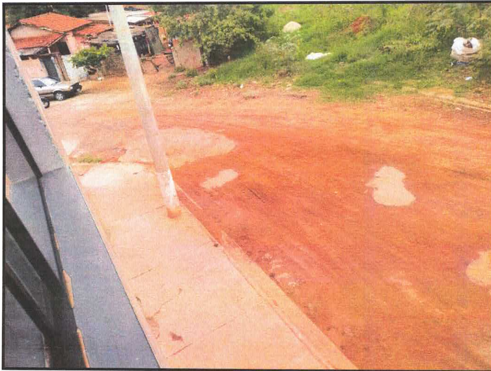
Imagens: rua Distrito Federal, altura do nº 458, Vila Santa Rosa.
