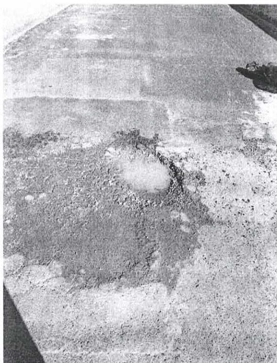
Imagens: Rua Belchior de Souza, especificamente na altura do número 403, no bairro Nenê Pereira Lima
