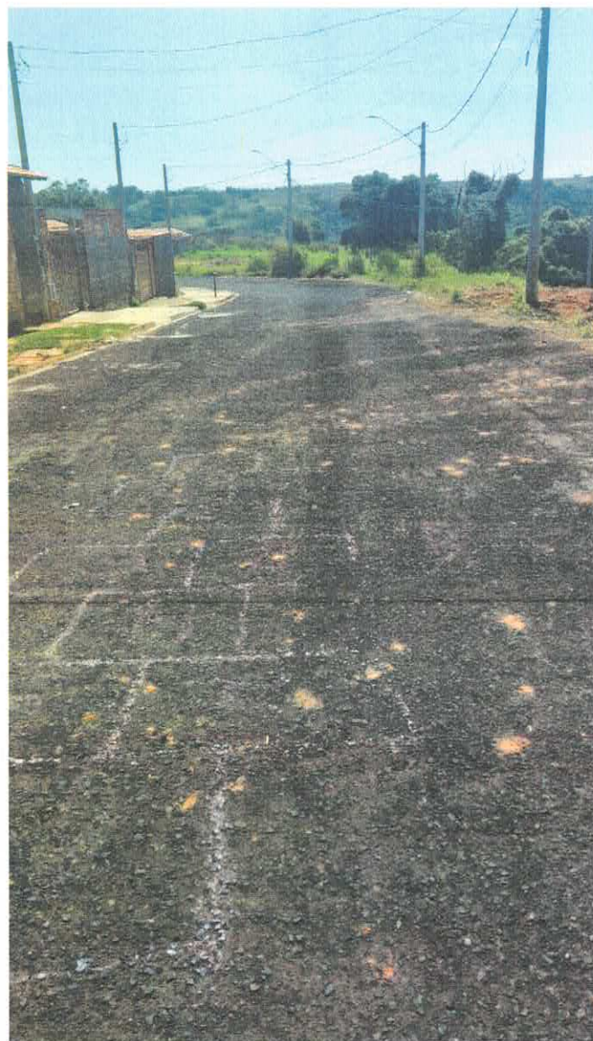
Imagens: pavimentação asfáltica do bairro Vicente Martins, no Distrito de São Benedito das Areias
