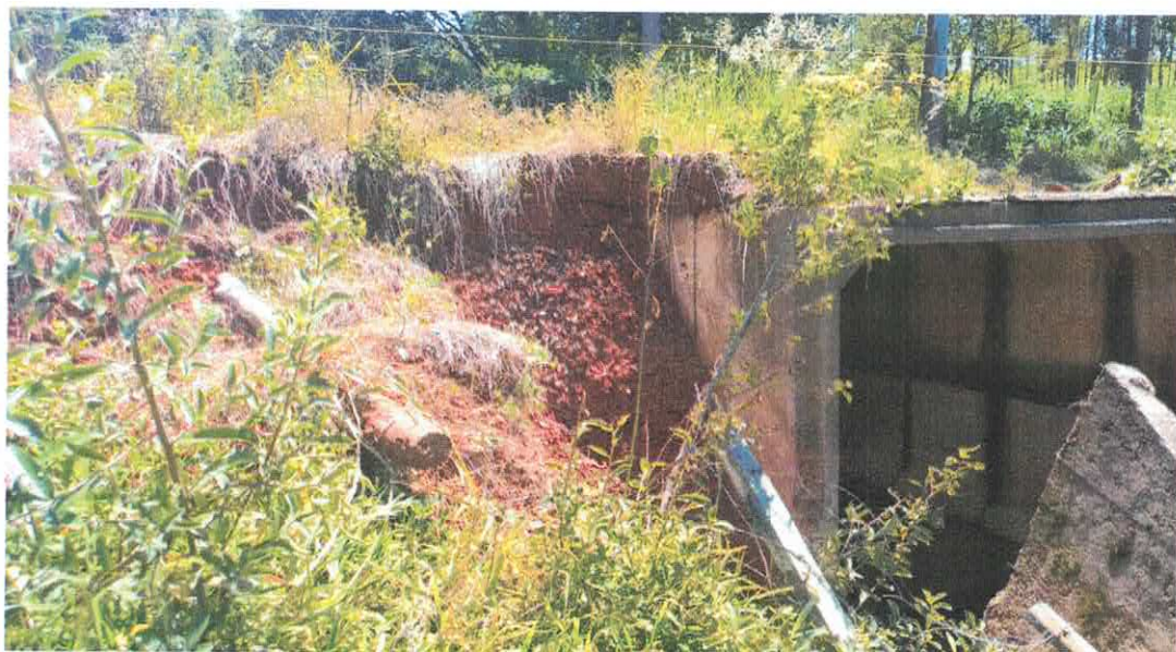
Imagens: ponte na divisa entre Mococa e Cássia dos Coqueiros
