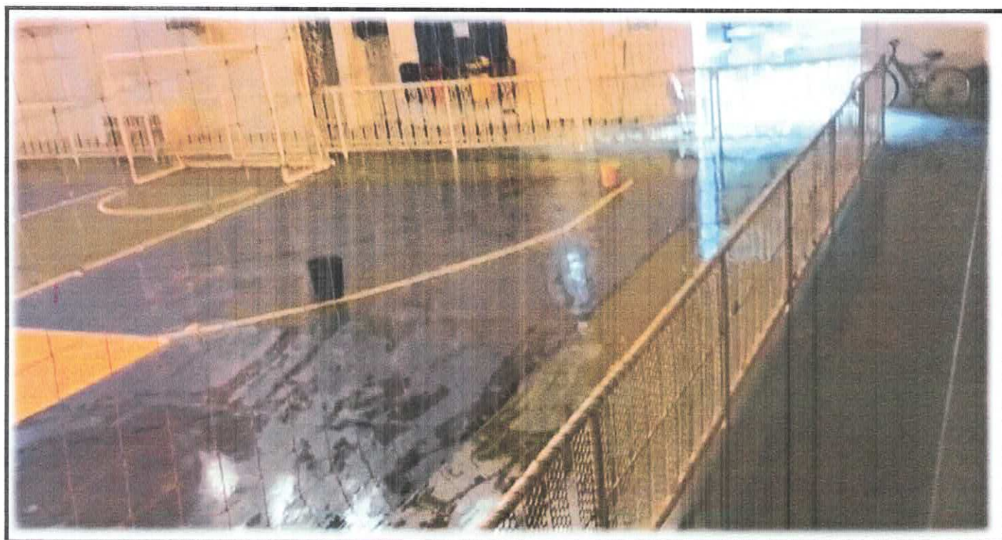
Imagens: telhado do Poliesportivo "Antônio Marin", no Distrito de Igarai.
