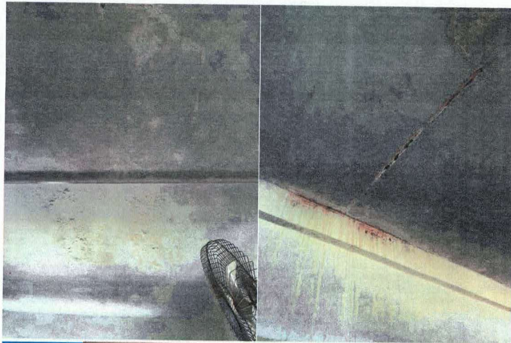
Anexo: Imagens da atual situação do prédio do Posto de Pronto Atendimento (PPA).
