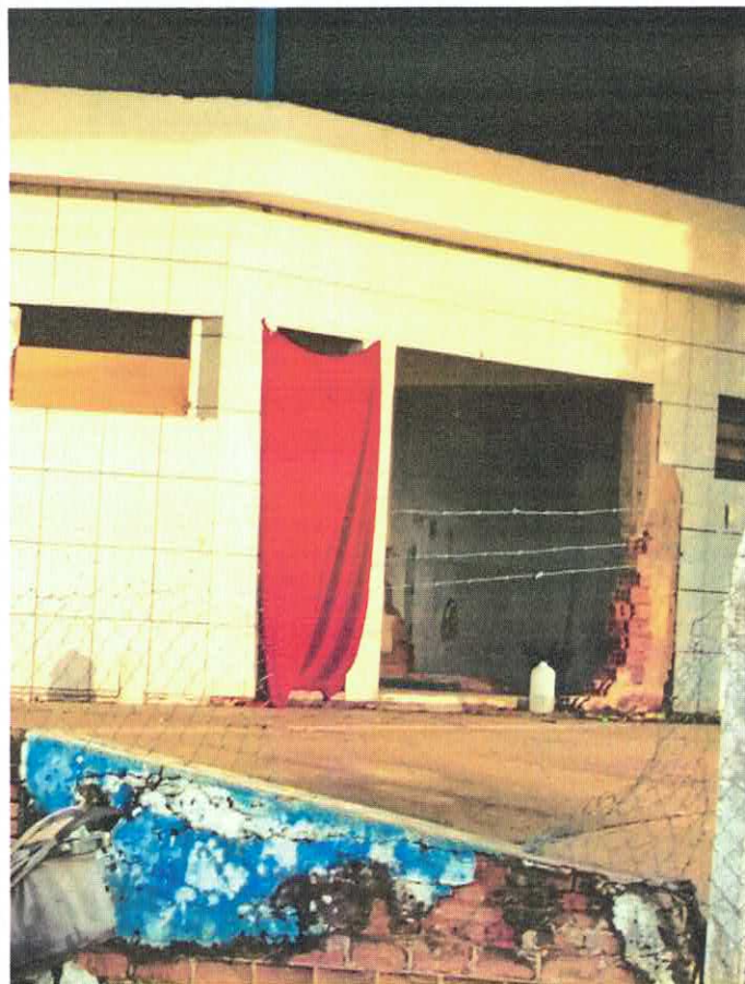
Anexo: Imagens do posto de combustível em situação de abandono (encontro das Avenidas José Justi e Cristóvão Lima Guedes).
